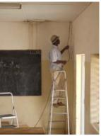
Gleich darauf legten die drei Techniker Dimas, Basil und Simplice mit der Arbeit los: während zwei von ihnen die Kabel verlegen, klettert der andere schon auf das Dach, um die Halterung für das Solar-Paneel zu installieren.
