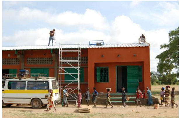
Installation der Solaranlage auf dem Schuldach
