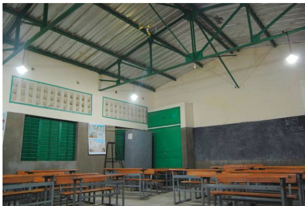
Das nun hell erleuchtete Klassenzimmer
